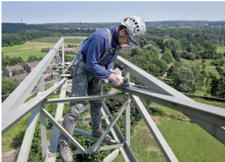
Abb. 2: Prüfer auf einem Strommast
