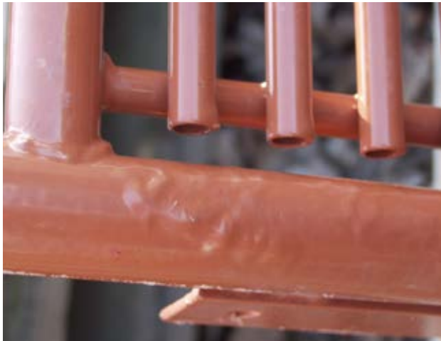
Abbildung 11: unverputzte Zinkverdickung
