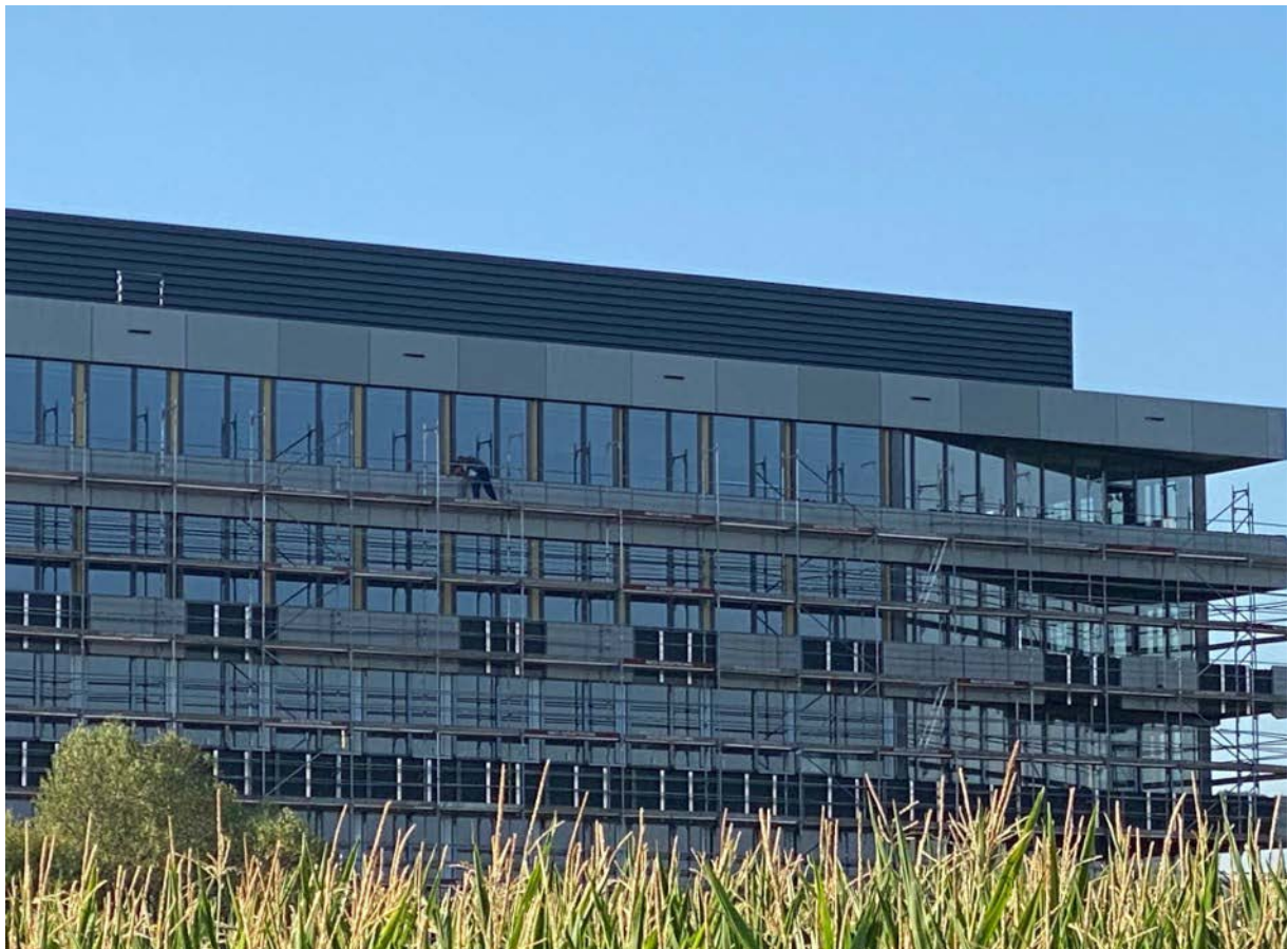
Farbunterschiede an einer Fassade
