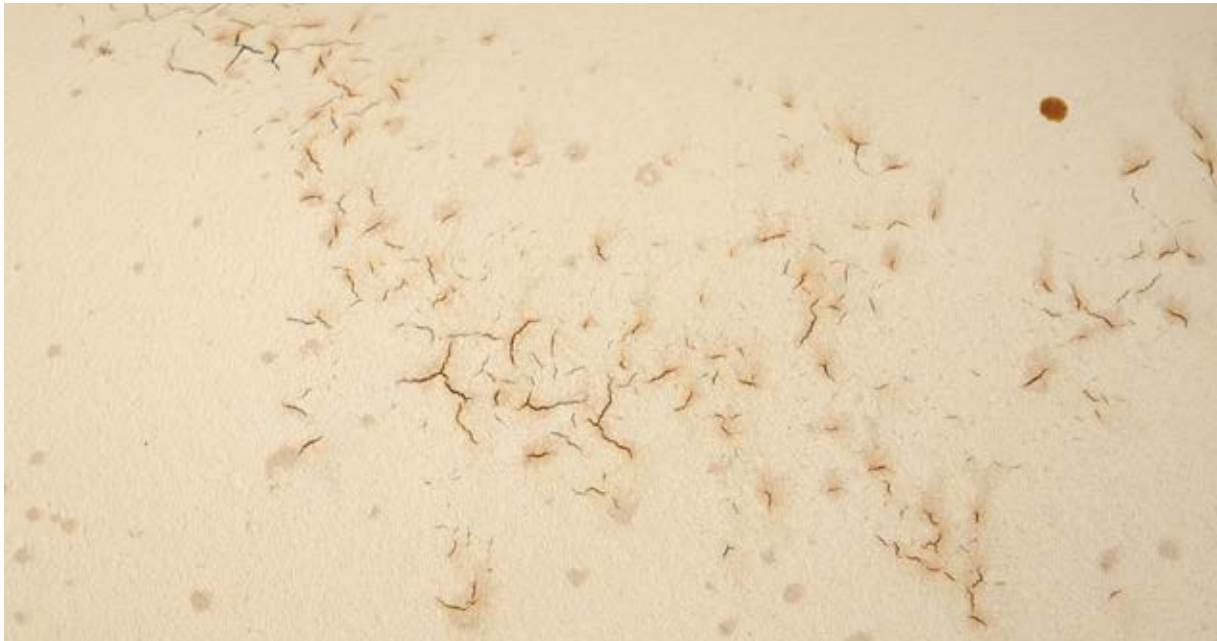
Abbildung 9: Korrosion auf dem Substrat
