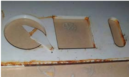
Versuchsblech mit abgeplatzter Beschichtung an der Laserkante
