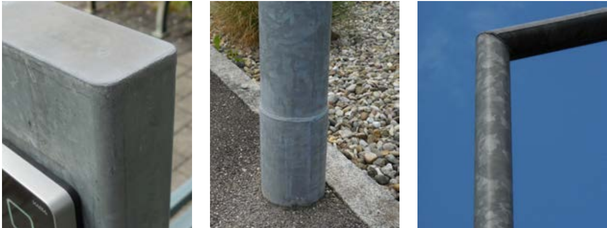
Abbildung 4: Beispiele für geschlossene Hohlbauteile. Links: Metallpfosten. Mitte und Rechts: Detailaufnahmen von Schweißnähten an einer Straßenlaterne
